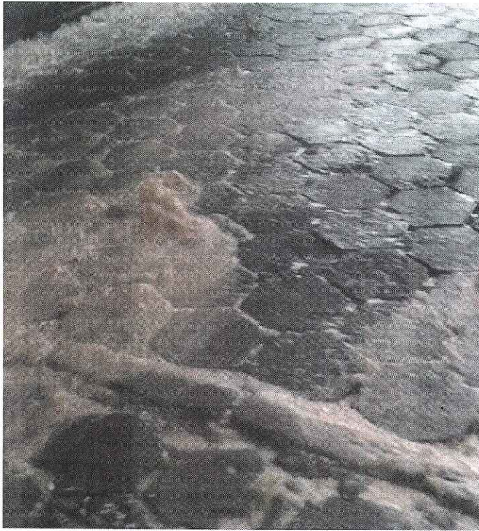
Figura 4 – Vista do Rua Leonor de Barros, em frente ao imóvel n° 214 em direção à Av. Antônio Edu Vieira, esgoto escorrendo a céu aberto na rua e o lixo acumulado na calçada pela falta de lixeira coletiva.
